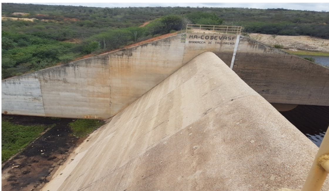
Figura 07 - Barragem Taquarendi, necessidade de pintura do nome da barragem, da régua e guarda corpo
