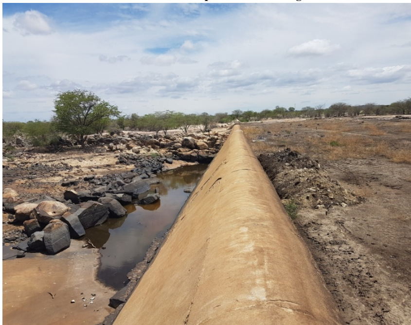
Figura 18- Barragem Poções -Revestimento da barragem de pedra argamassada com rachaduras
