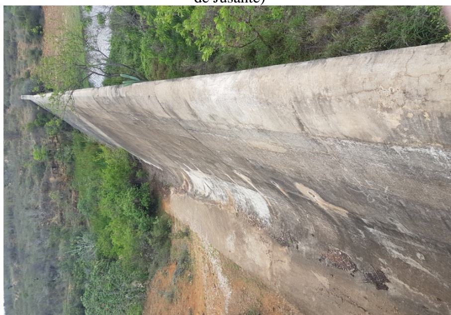
Figura 17 - Barragem Caatinga do Moura, Vista da estrutura vertente em concreto ciclópico (perfil do tipo Creager)
