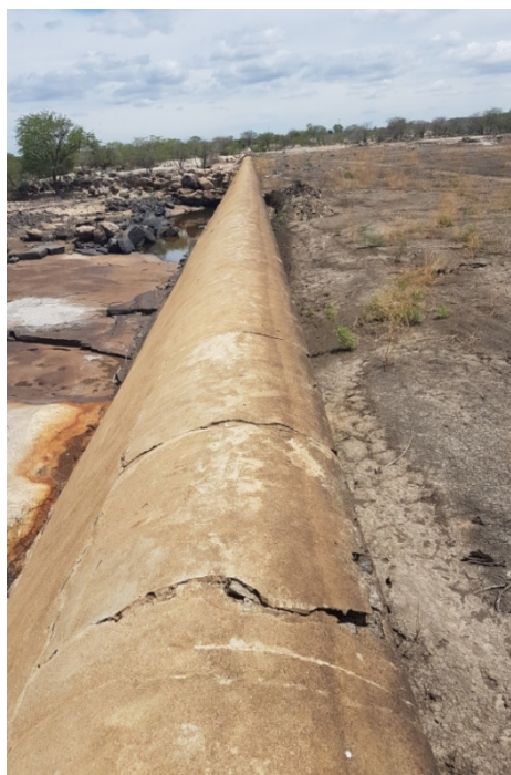
Figura 18- Barragem Poções -Fissuras na argamassa que reveste a alvenaria em pedra argamassada.
