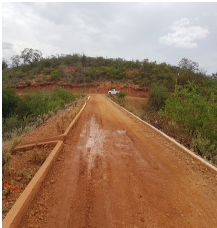
Figura 12 - Barragem Poço da Pedra, regularização da crista
