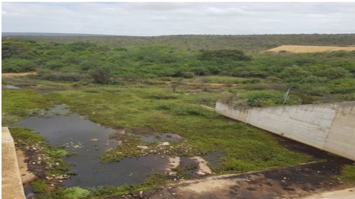
Figura 04 - Barragem Taquarendi, vegetação no vertedouro
