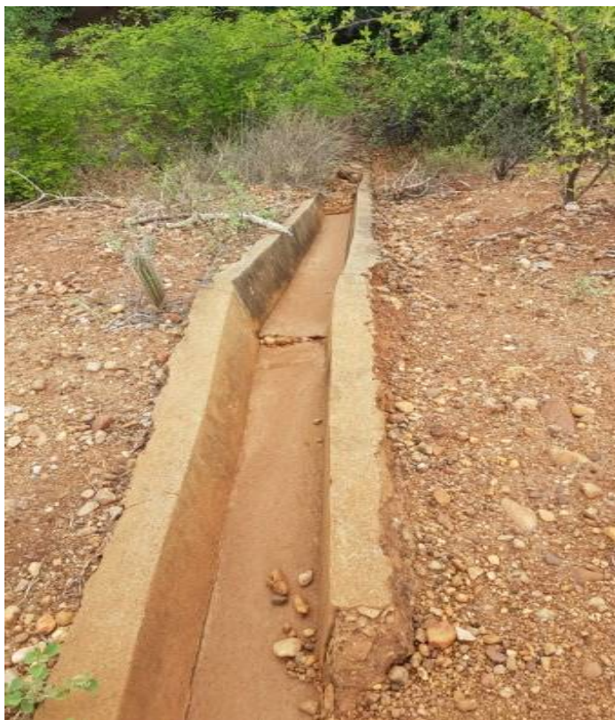
Figura 11 - Barragem Poço da Pedra - recomposição e limpeza de canaletas de drenagem
