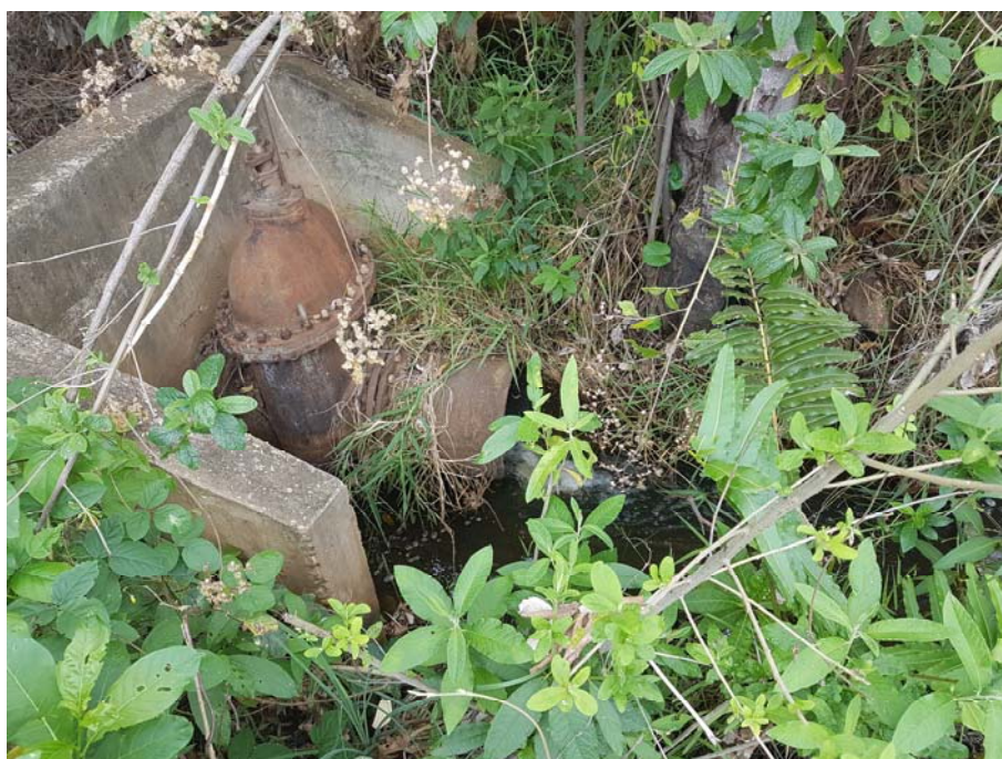
Figura 16 - Barragem Caatinga do Moura ,Vista do registro de controle da vazão na estrutura de saída da tomada d'água, excesso de vegetação.
