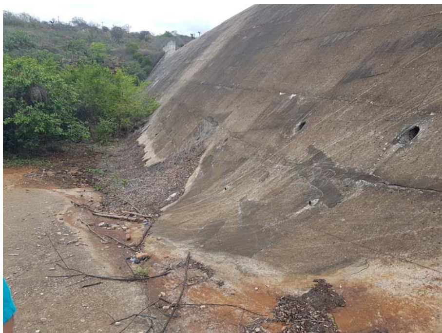
Figura 19 - Barragem Caatinga do Moura , Vegetação próxima ao pé do talude de jusante
