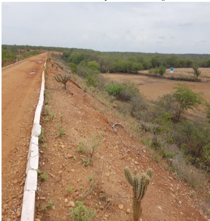
Figura 10 - Barragem Poço da Pedra, excesso de vegetação
