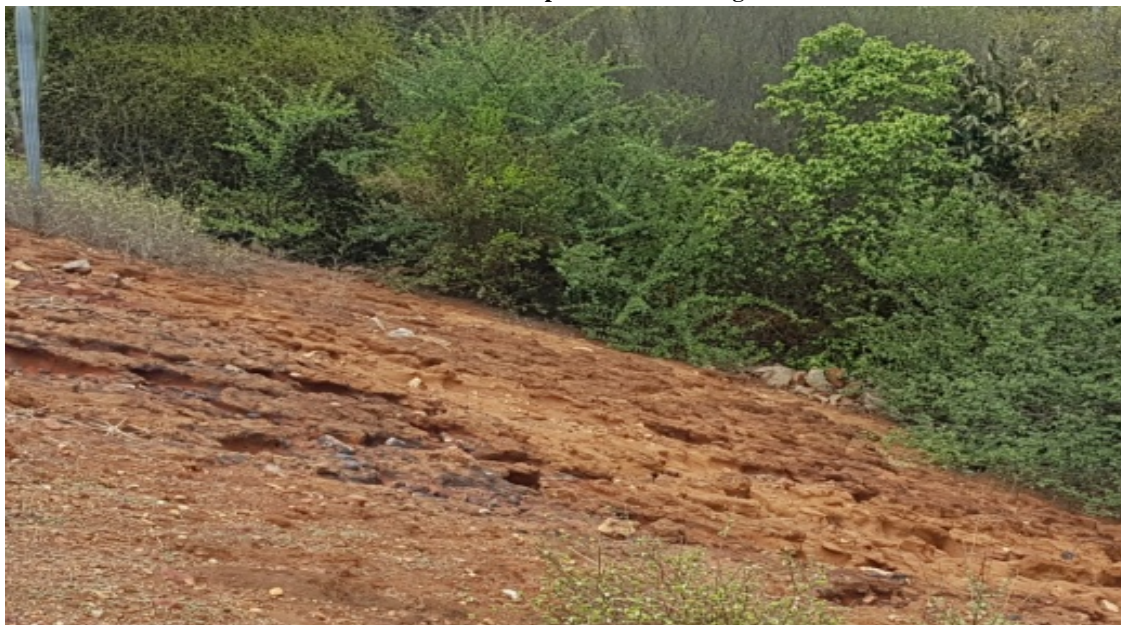
Figura 06 - Barragem Taquarendi, erosão, vegetação e falhas nas pedras de dissipação da água pluvial
