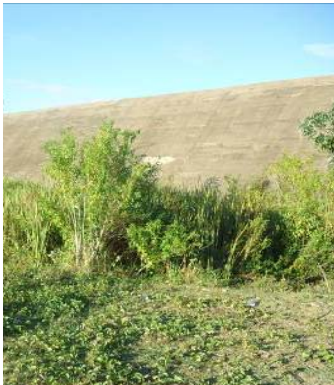
Figura 20 - Barragem Caatinga do Moura - Excesso de vegetação à montante
